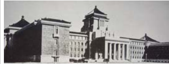
新首都となった新京で、関東軍司令部と並んで立てられた豪壮な建物は 国務院の新庁舎だった。写真は完成直後の国務院 ca.1936
